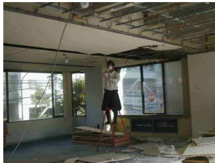
天井せっこうボード・吸音岩綿板の解体作業
