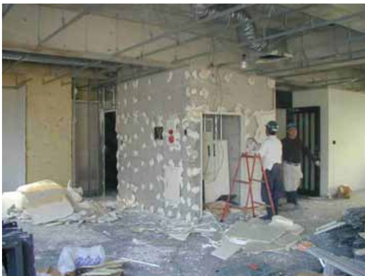
壁せっこうボードの解体作業
