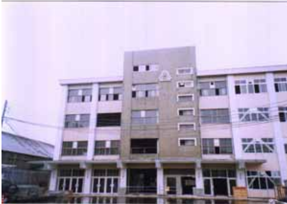
改修前（内部解体完了時）
