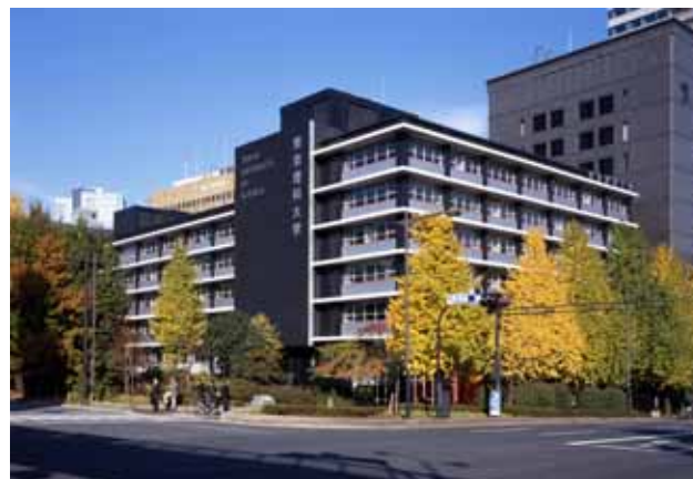
改修後 南西外観(2005(平成17)年改修)
