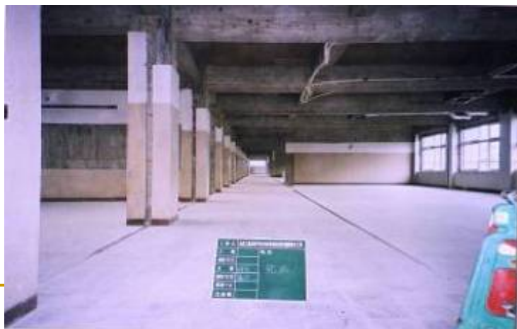
(3) 躯体劣化部補強完了
