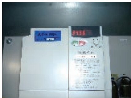
現在34.56Hzにインバーター制御し適正に運転している。この数値が50Hz付近から動かない場合は正常に機能していない可能性がある。
