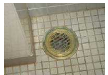
トイレの床上排水口
