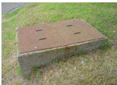
大きな量水器樹です。中に200mmのメーターが付いています。
