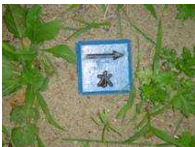
地中埋設標(水用) 管のルートも表示されています。
