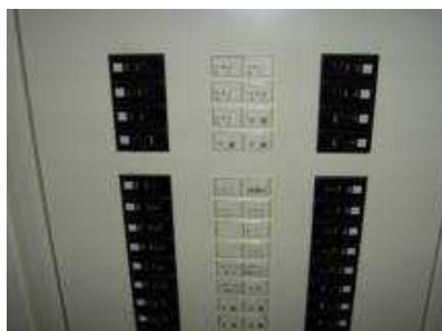
盤の扉を開けると、回路毎にブレーカーがあります。また、何の回路か分かるように回路名も書かれています。
