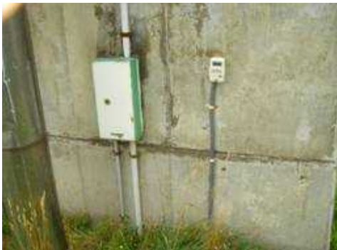
某所にある引込開閉器函 (扉部分落下の恐れがあり、テープにて固定)
