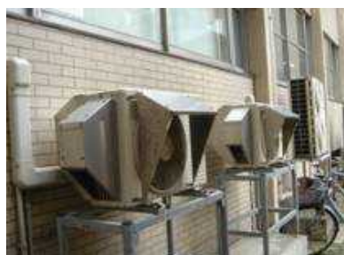
機器本体以外にも、支持架台、基礎もチェックしましょう！
