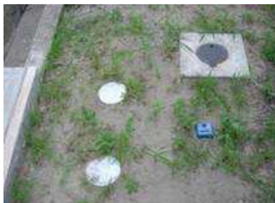
右上) 弁樹50mmのバルブ用 右下) 地中埋設標(水用) この下に水道管が埋まっていることの目印になります。 左) 白い2個の丸いものは小口径塩ビ製汚水樹の蓋です。重量が軽く、小型で施工性が良く、コンクリート樹に比べて安価である。
