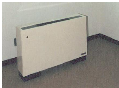
ファンコイルユニット
