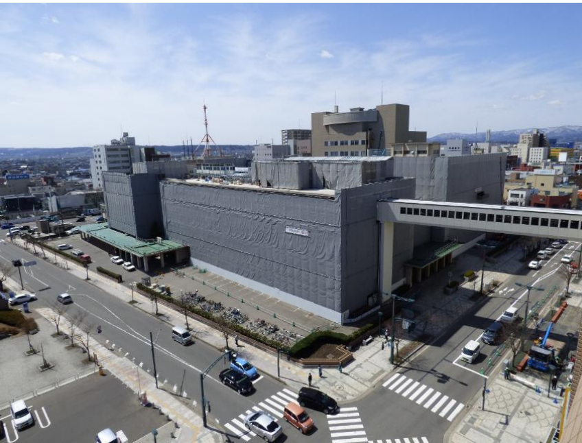
工事の状況 H29.4.10撮影
