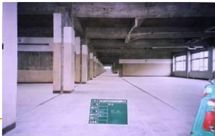
(3) 躯体劣化部補強完了
