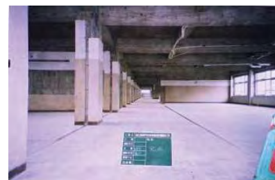
(3) 躯体劣化部補強完了
