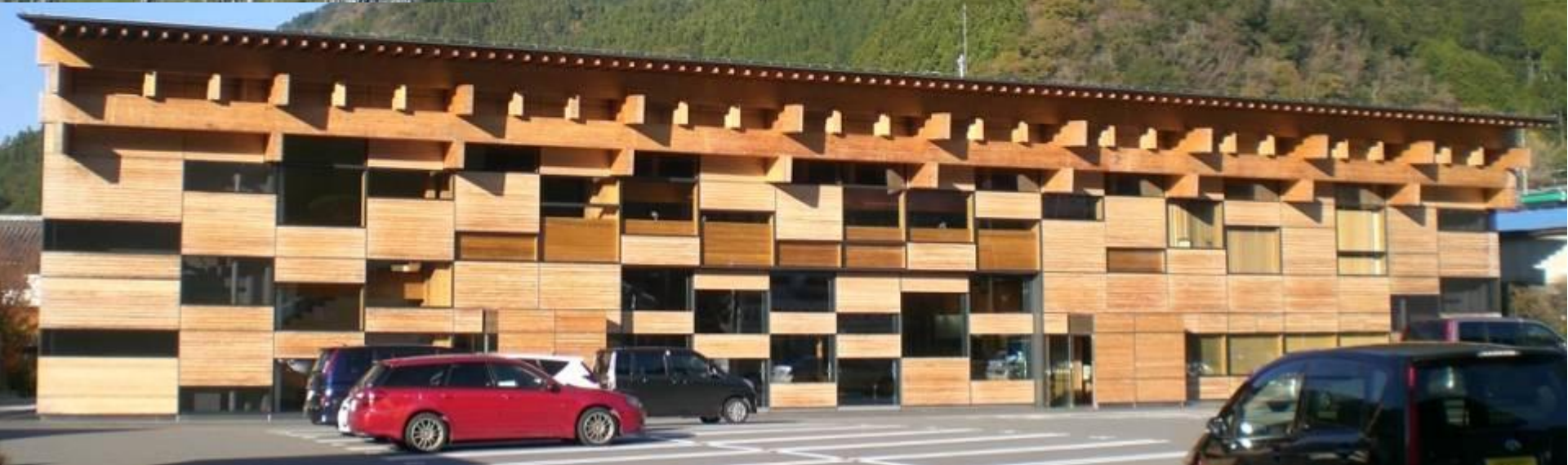
600kW×2基 町営風力発電所
