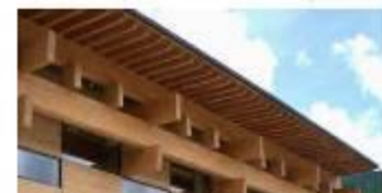
南面の深い庇・梶原産木材外装パネル・古紙発泡断熱材
