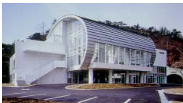
リファイン後（役場庁舎） 【外観】
