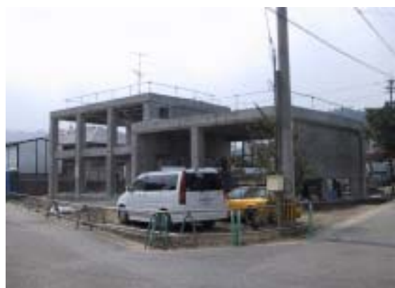
リファイン建築工程 （不要部分撤去時：福岡市西陵公民館）
