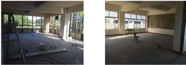
改修中(スケルトン状態)
