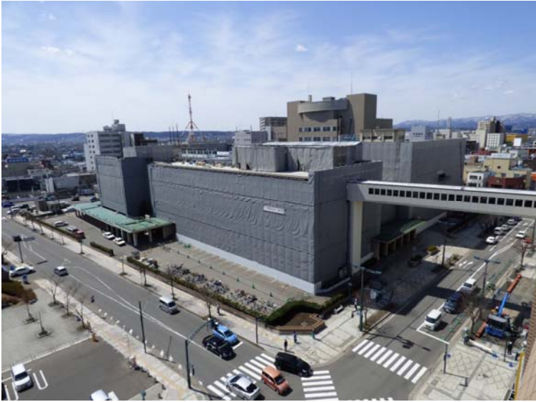
県庁舎耐震・長寿命化改修工事の状況 H29.4.10撮影
