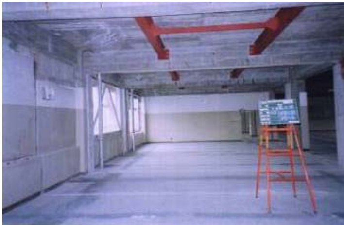
(3) 躯体劣化部補強完了
