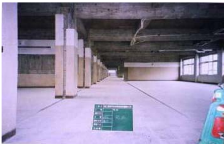
(3) 躯体劣化部補強完了
