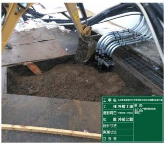
エアコン用埋設配管 埋め戻し
