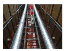
PC工事のシース菅を捨て筋に固定し、打設時の移動を防止
