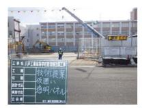
透明仮囲いパネルによる見通し向上による衝突事故を防止
