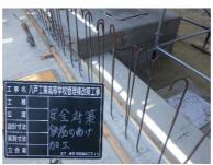
差し筋曲げ加工による転倒時、足場転落時の刺創を防止
