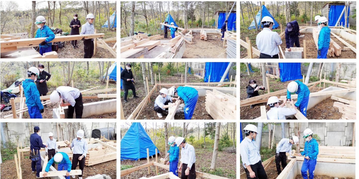
2日目は校内の実習場で工作機械の電気角のみを使い、部材加工をしていただきました。その後、東通村上田代の小屋の建設現場に移動してコンクリート基礎に設置する土台敷をするため、部材の運搬と土台部材にアンカーボルトを通す穴の加工を訓練生と一緒に体験し、実際に基礎上端に土台を設置しました。初めて体験する作業が多くありましたが、「ものづくり」本来の厳しさや楽しさを感じていただけたと思います。
