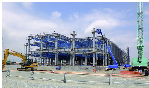
新築工事(鉄筋)
