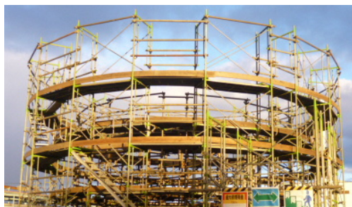
タンク建設工事
