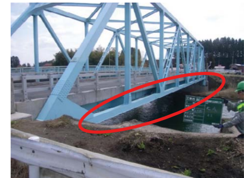
(塗装塗替等により、防食機能を回復)
