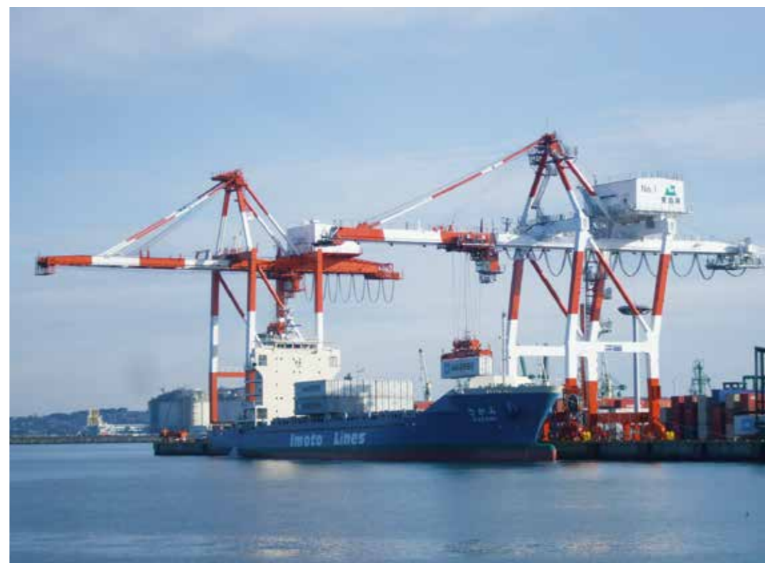
東日本大震災からの復旧を終え、復興に向けて動き出した八戸港
