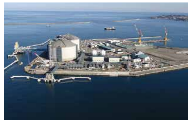
八戸LNGターミナル（建設中）
