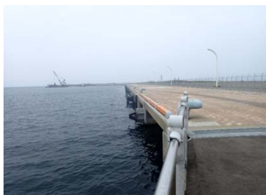
【耐震強化岸壁】L=280m
