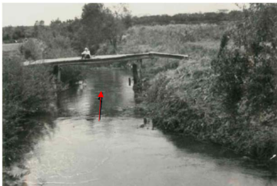
事業実施前の状況
