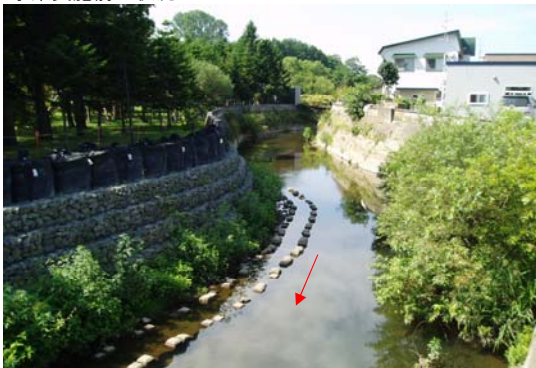
事業実施前の状況
