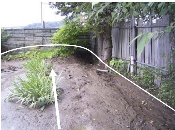
平成18年8月の豪雨による被災(土砂流出)
