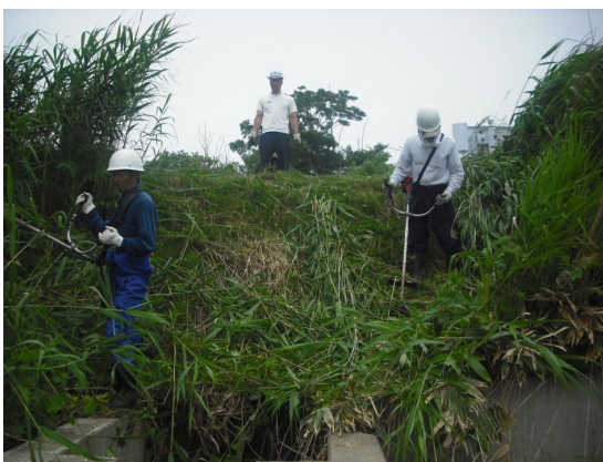
③底樋及び用水路の草刈り状況
