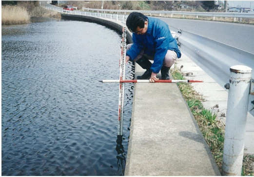
【堤体の状況(着工前)】
