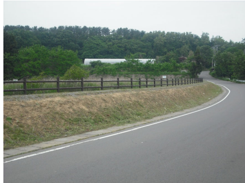
【堤体の現在の状況】漏水は見受けられない
