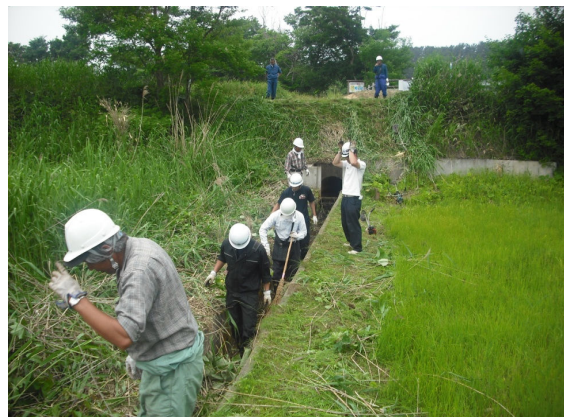
④用水路の清掃状況
