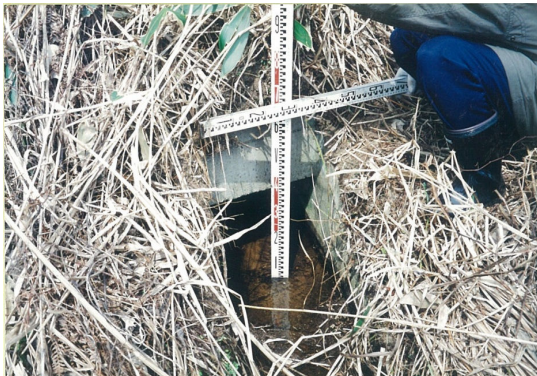
【底樋の状況(着工前)】
