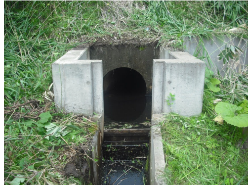
【底樋(現在の状況)】
