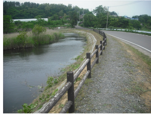
【堤体の状況(現在の状況)】
