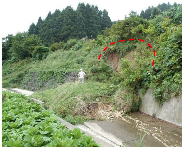
4ブロック末端部の表層崩壊(H17.9)
