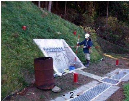
1ブロック 横ボーリング工
