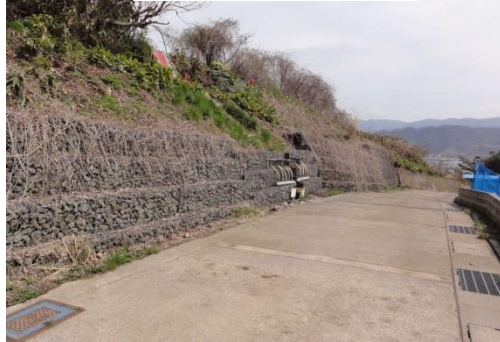
4ブロック 横ボーリング工
