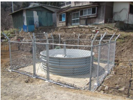
3ブロック 集水井工
