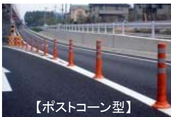
① 中央分離帯構造の見直し(イメージ)
