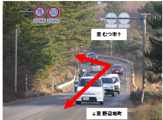
② 急カーブ箇所における視距不良状況
