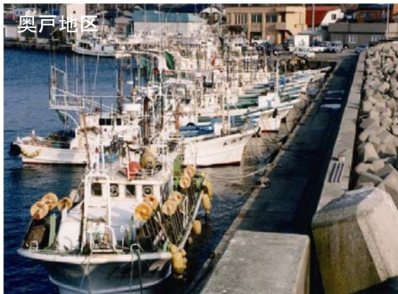
係船岸の整備不足から防波堤を係留施設として代替利用している。
