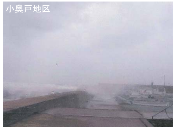
係船岸の整備不足から防波堤を係留施設として代替利用しているが、港内静穏度が悪いことから、漁船同士の接触等による漁船の破損被害が発生している。
