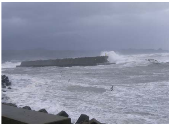
静穏度が確保されておらず安全な係船が困難なため、第4南防波堤を早期に完成させる必要がある。(H22.4撮影)
