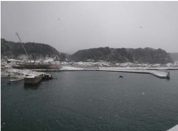
-3m泊地及び新荷捌所の状況(H23.1撮影)
