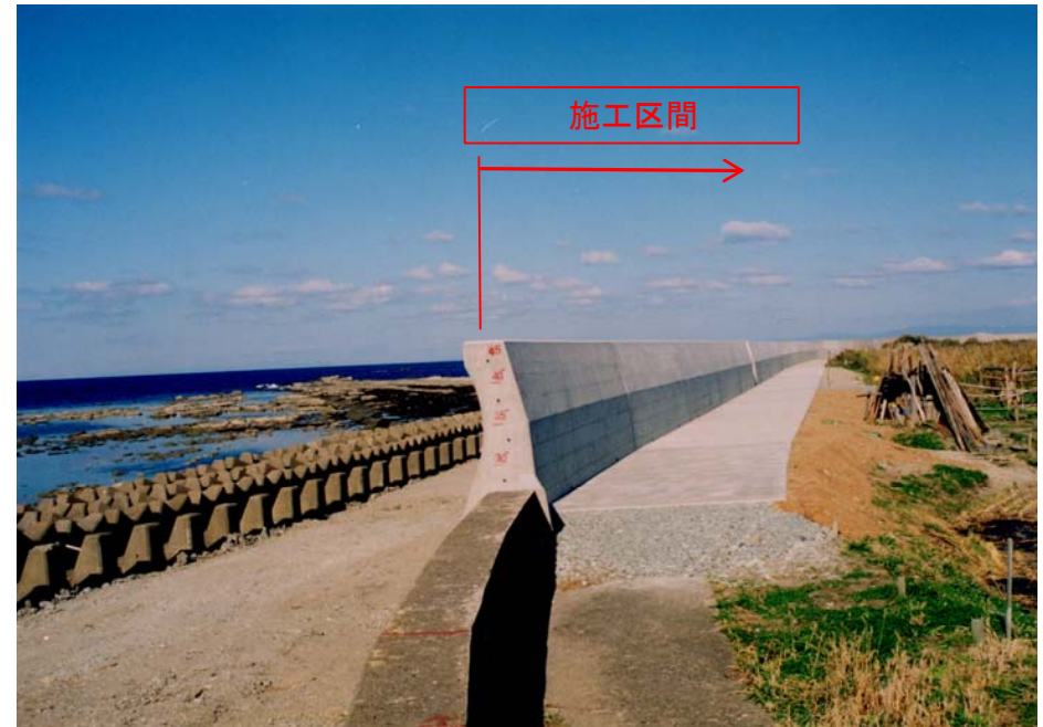
嵩上げされた護岸工 (TP+3.50m → TP+5.00m)
