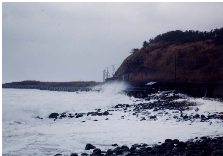
冬期の越波状況(護岸工嵩上げ前の状況) ( TP+3.50m )
