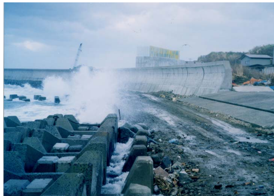
冬期の日本海の波浪状況と嵩上げ後の護岸工 ( TP+5.00m )
