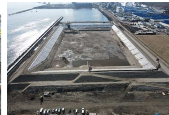
浚渫土砂処分場(八戸港八太郎地区市川)
