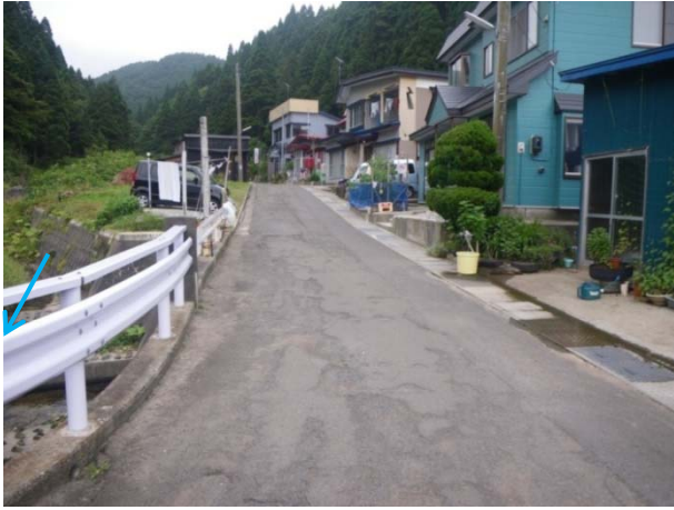
保全人家・町道
