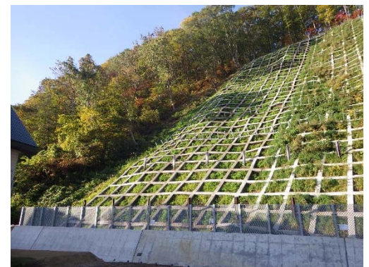
現場打吹付法砕工(砕内植生吹付)
