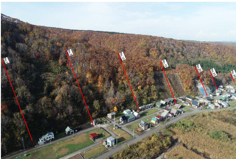
全景写真(施工起点側から)
