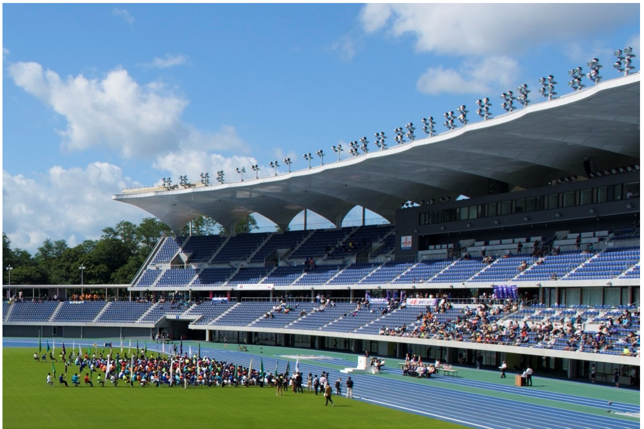
令和元年9月 追加整備箇所：「陸上競技場」の利用状況
