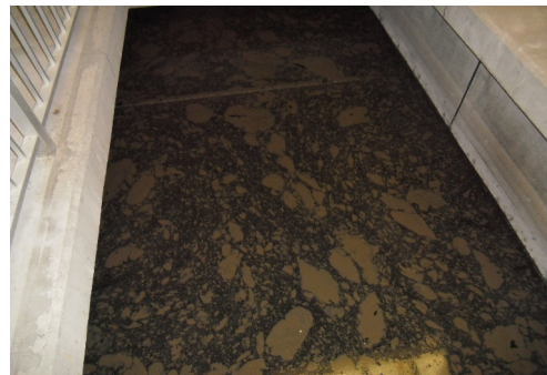
写真1 処理前の汚水の様子(最初沈殿池)
