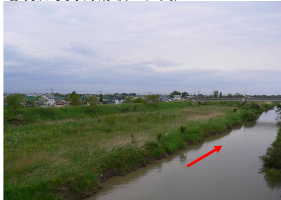
②現況写真(改修済み区間)
