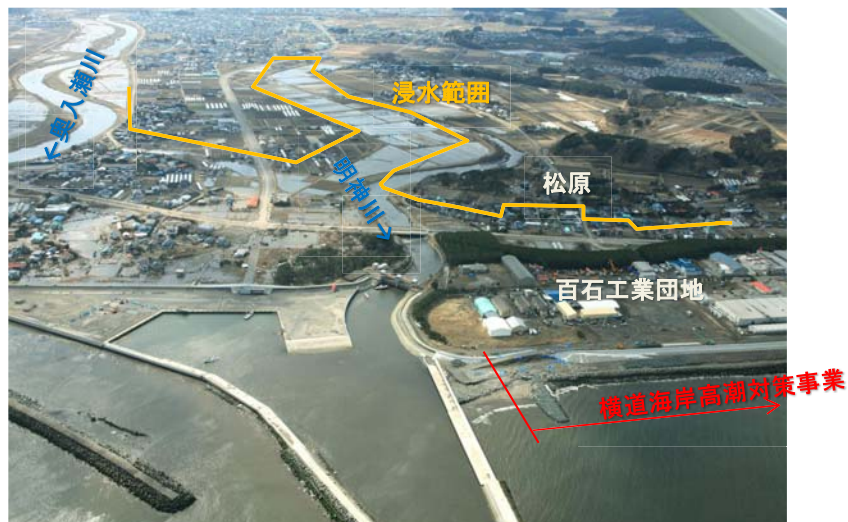
被災状況(東日本大震災)
