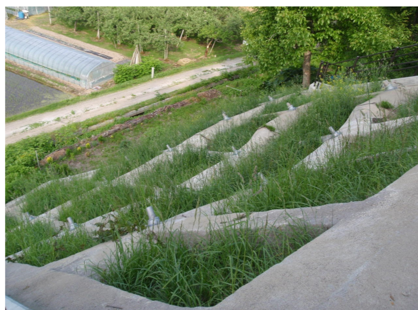
長崎区域 上方より(施工年度H21) 施工後約3年経過植生状況(撮影月日H24.5.25)
