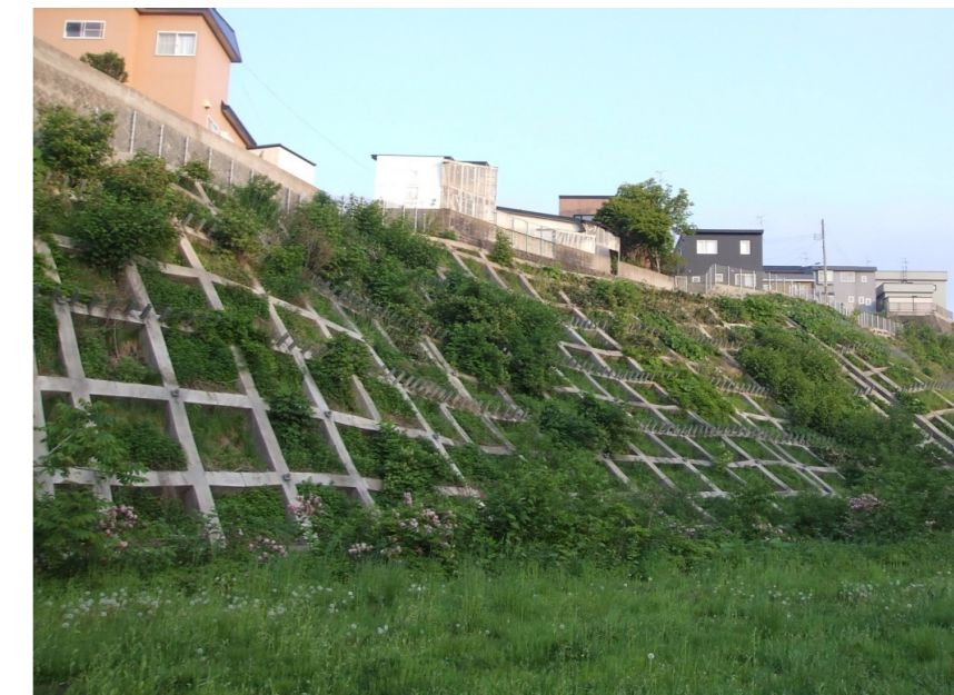
平岡1号区域 青森市新城地内 (施工年度H19) 施工後約5年経過植生状況(撮影月日H24.6.1)
