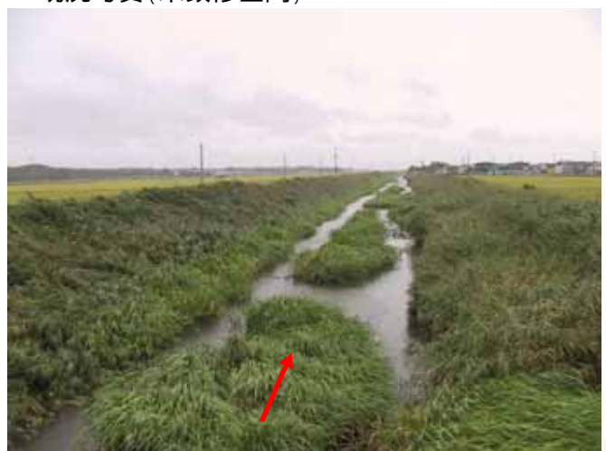
現況写真(未改修区間)
