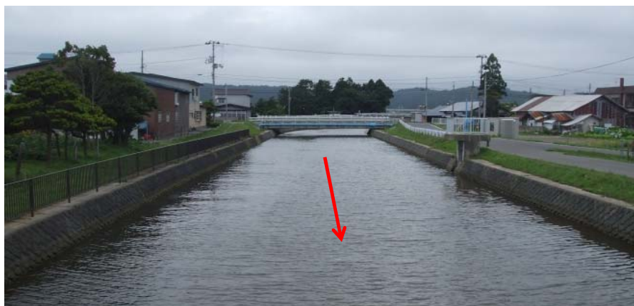
【事業実施後の状況】(宮川橋から奥内橋方向)
