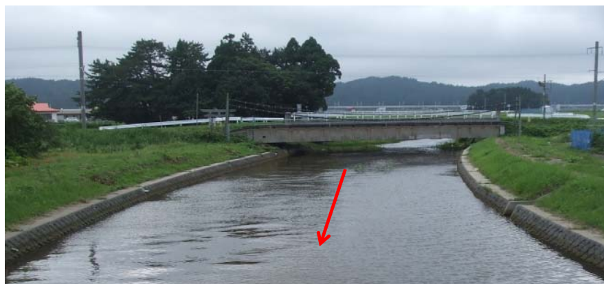
【事業実施後の状況】(奥内橋から津軽線方向)
