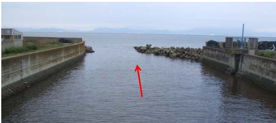
【事業実施後の状況】(宮川橋から河口方向)
