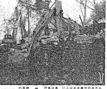
奥入瀬・山崩れ
