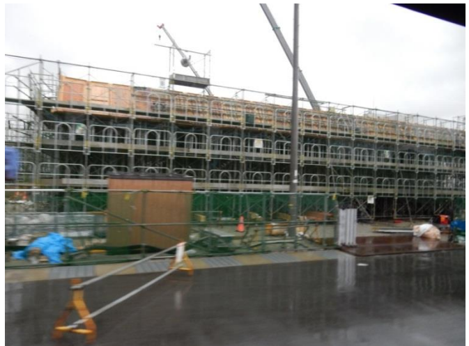
建設中の荷さばき施設
