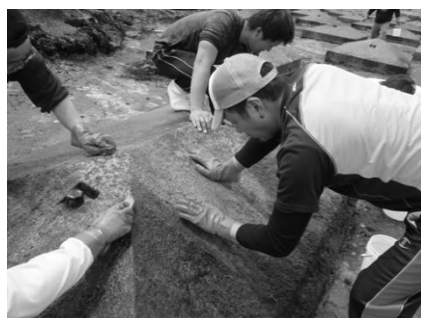
写真-3 人工礁表面の雑物除去
