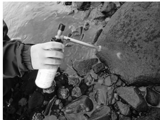
写真-8 ガスバーナーによる雑物除去
