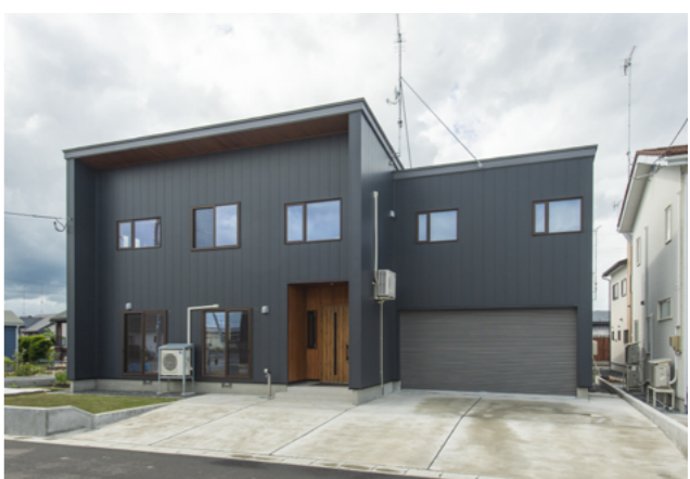
黒を基調にした、クールなイメージの外観。玄関と屋根の内側に張ったスギの木がアクセントに。
