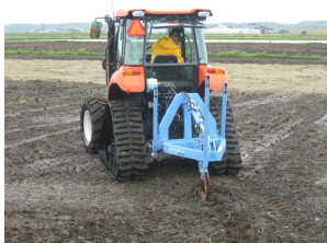
カットドレン施工(R1.5.21)
