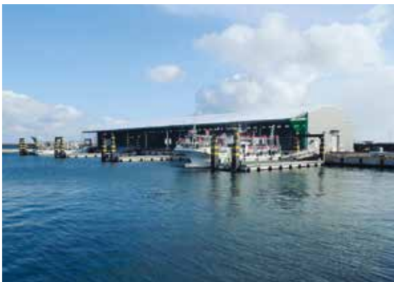
高度な衛生管理に対応した荷さばき所の整備 (三沢漁港)
