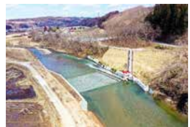
整備された頭首工（田子町）
