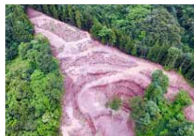
樹種転換の施工地（南部町）
