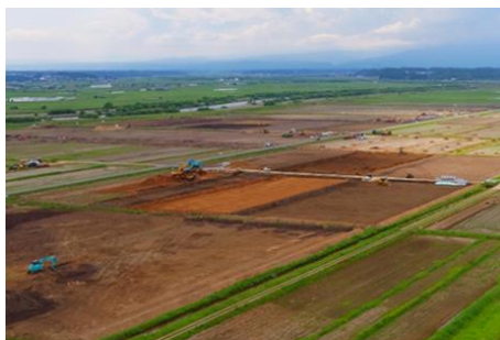
区画整理工事の状況 (七戸町・東北町 土場川地区)
