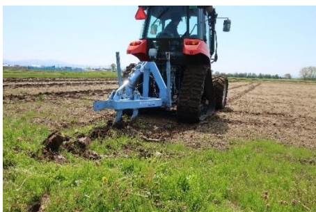
穿孔暗きょ機(カットドレーン)の施工
