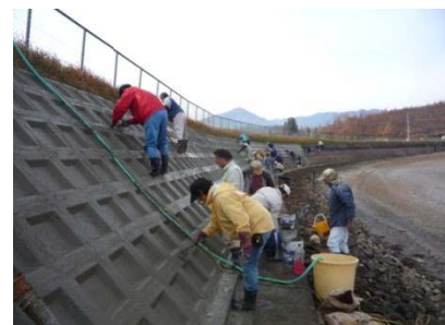
写真4 コンクリートブロック・目地等補修（長野県）
