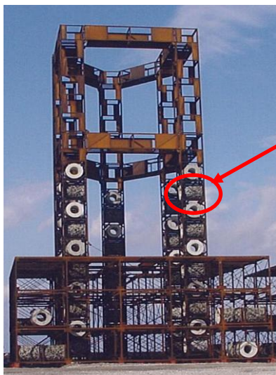
鋼製高層魚礁（高さ21m）
