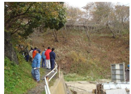
人家裏の急傾斜地の状況確認
