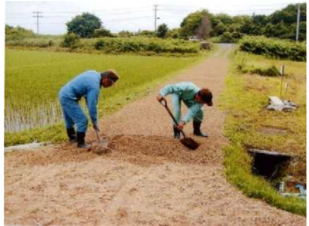
農道の補修作業
